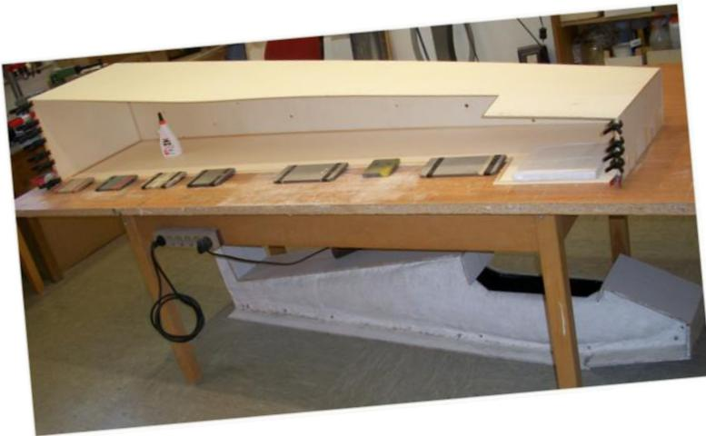
Die Kanten werden ringsum mit Kieferleisten (5x5) verstärkt.
